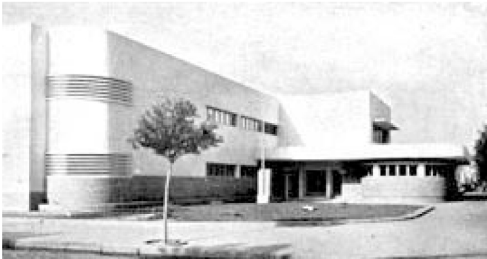
Imagen 1. Fachada y Plaza de acceso, Escuela N°5 López y Planes, desde calle Tucumán. Santa Fe, Argentina. 1939.
