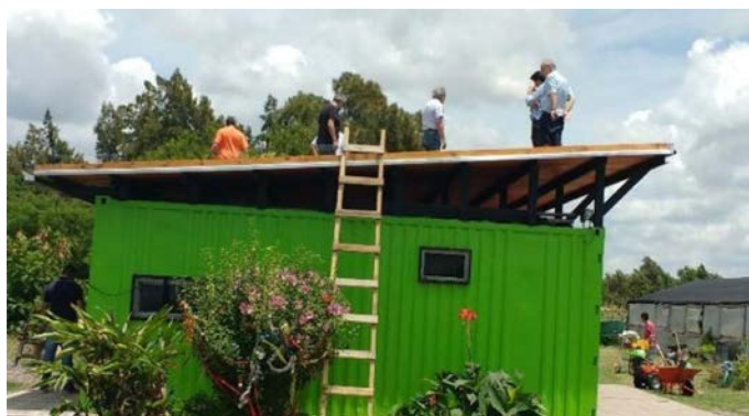
Figuras 2, 3, 4 y 5. Proceso de construcción y armado de la cubierta verde.
