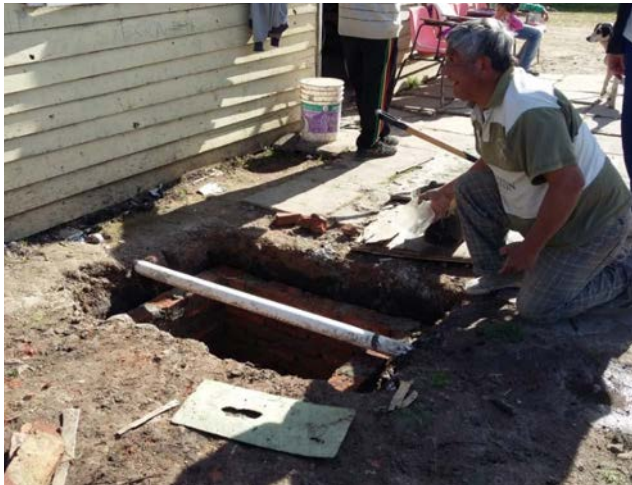
Imagen 3. construcción de la cámara séptica.
