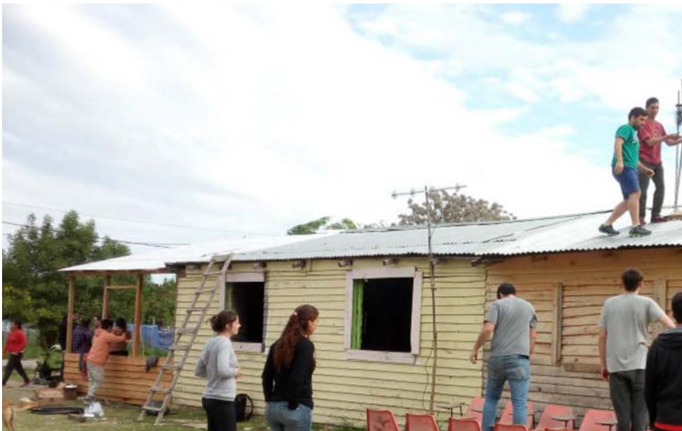
Imagen 2. grupo de trabajo instalando el calentador sobre el techo del comedor.
